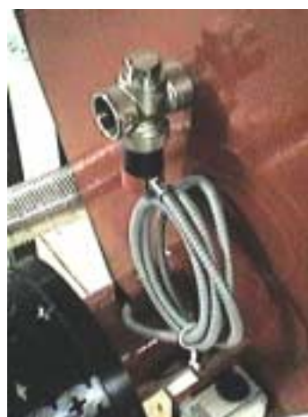
Fig 5 Bilden visar monteringen av vattensprinklern som är det enda egentliga skyddet mot bakbrand
