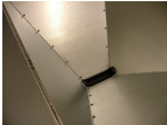
Man bör inte vara snål på fogmassan då det är viktigt att det blir dammtätt.
