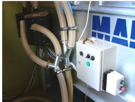
Vakuumsugar och styrskåp monterat.
