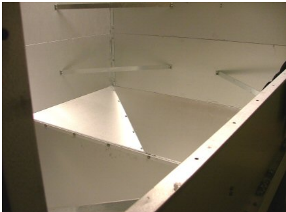
Vänta med att montera den sista sidoplåten då det är lättare att komma i och ur förrådet vid monteringen av skruven.
