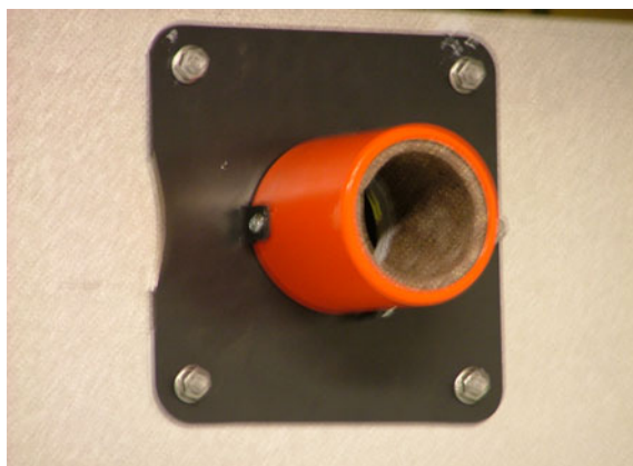
Adaptern till utblåset från vakuumsugarna monterat på bulkförrådets gavel.
