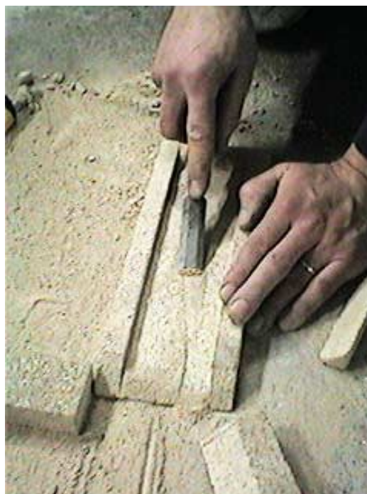
Bilden ovan visar konstruktionen av sekundärluftkanalen som placeras i eldstaden med bästa miljöresultat.
